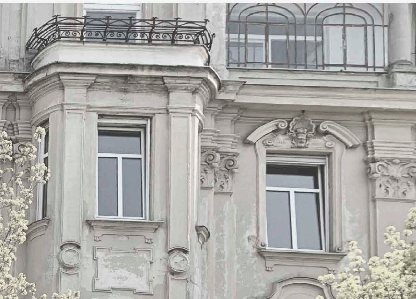
Fassade mit Verglasung des Wintergartens im 3. Obergeschoss
